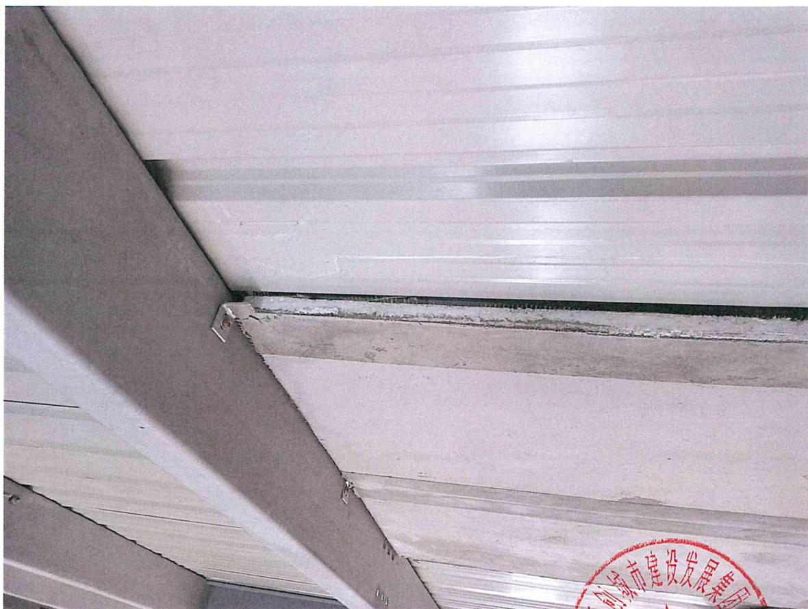
现场封样样板图：
